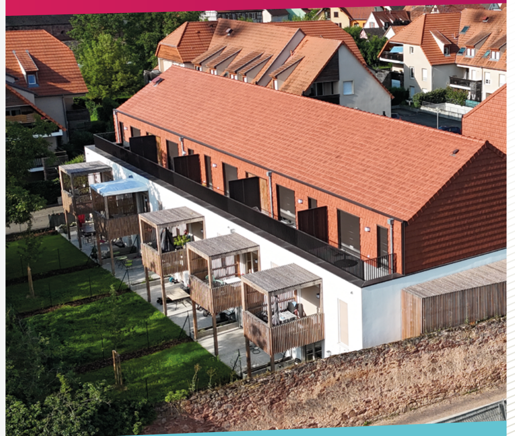
Résidence Clos de l'Abbaye - Altorf. Une résidence composée de 20 appartements en PLSA et 11 logements en LLS.
